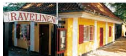
Ravelinen ligger lige ved siden af Christianshavn Metro station
