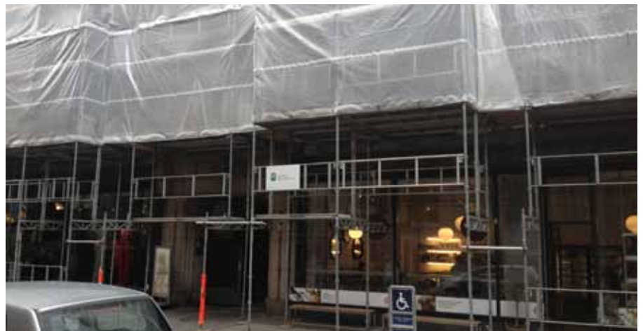
Lützau Totalentreprise ApS v/ Martin Lützau, er bortvist fra arbejdspladsen Store Strandstræde 19 – 21
