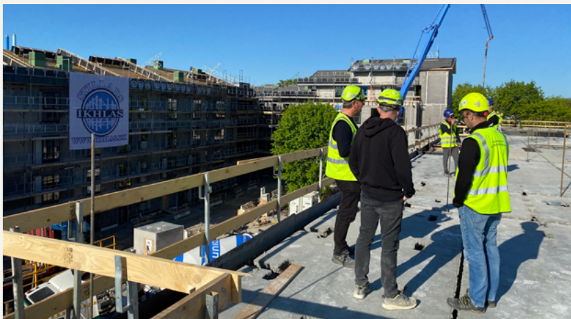
Byggefagenes Samvirke på pladsbesøg
