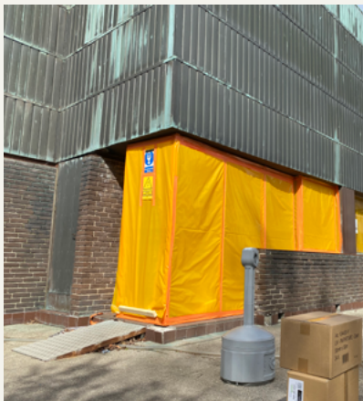
Der har været et større projekt igang på Lygten, for at fjerne asbest
