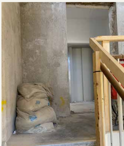
Faldfare på stilads og støv og rod på byggeplads samt i skuret.
